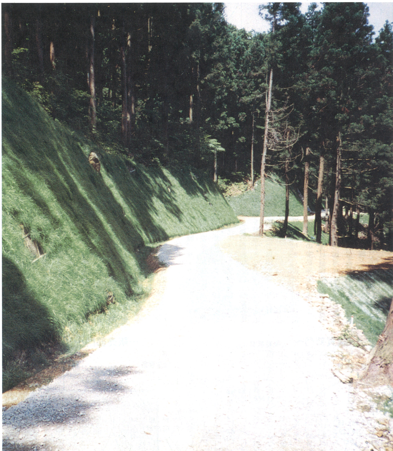
県単独補助事業（中核団地林業活性化路網整備）作業路 掛合町大字松笠地内（延長 440m 幅員 3m）
